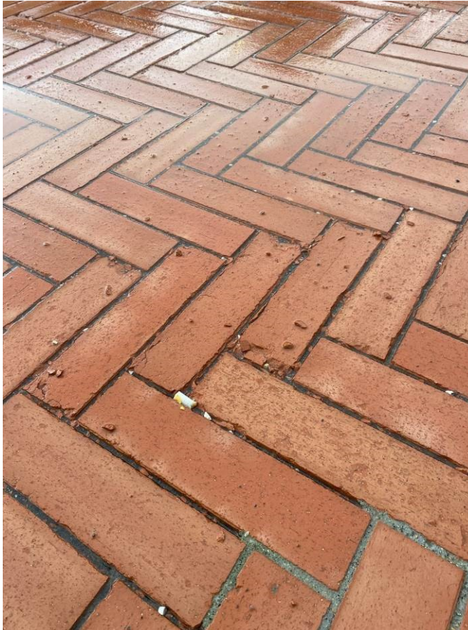
Mattonelle posate meno di un anno fa in stato di degradazione Febbraio 2020
