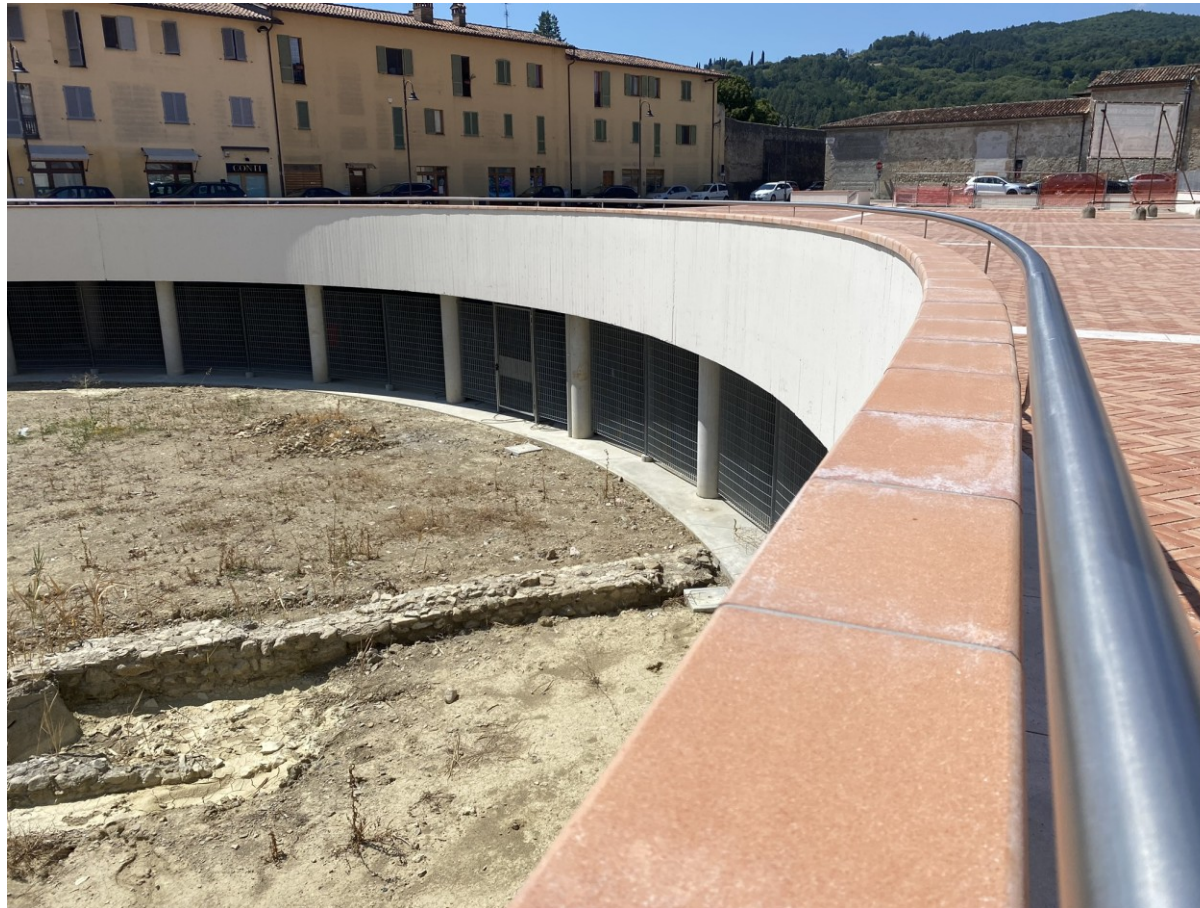
Vista grigliato parcheggio con parapetto Inox
