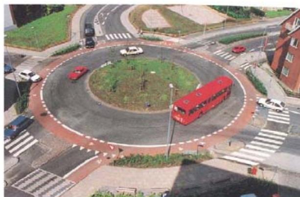
La documentazione fotografica allegata riporta il paradigma di Grosseto (rotatoria tra via della Repubblica e via Einaudi) dove la ciclabile in rotatoria (con anello interno) è protetta da apposita cordonatura, il conducente del veicolo in approccio alla rotatoria viene allertato da attraversamenti pedonali rialzati.
