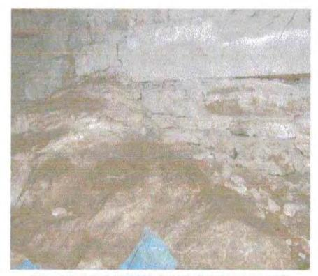
Foto n. 1 - Le fondazioni del fabbricato oggetto di ampliamento sono poste direttamente a contatto con compagine rocciosa inalterata.
